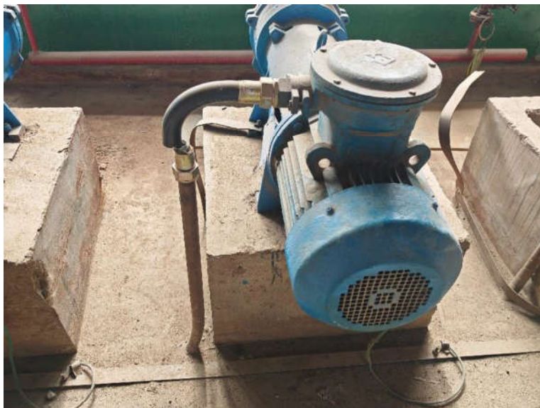
图 4.1-3 项目减震基础
