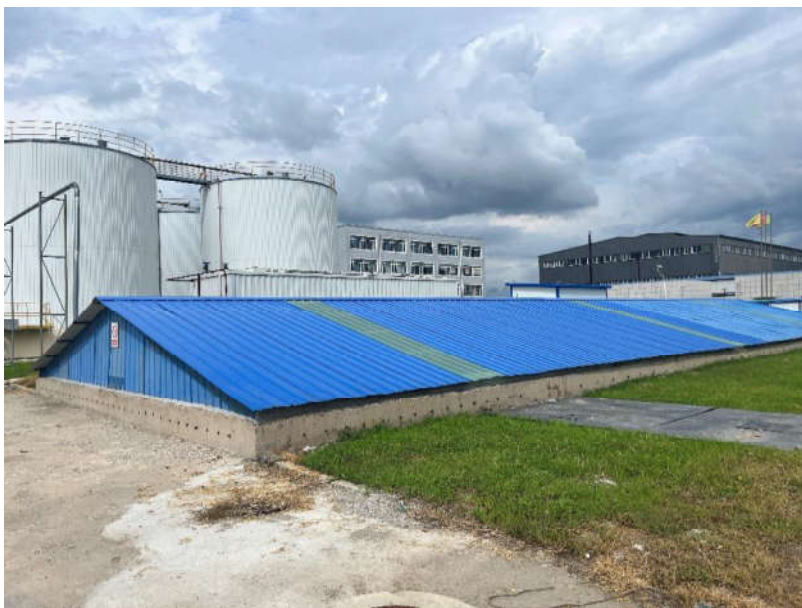
图 4.1-2 项目地埋式污水处理站
