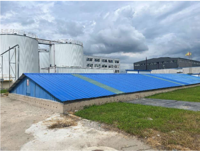
图 4.1-2 项目地埋式污水处理站
