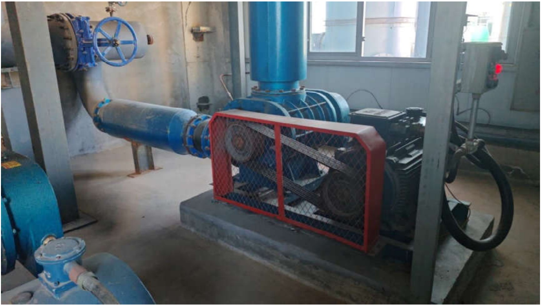
图 4.1-3 项目减震基础
