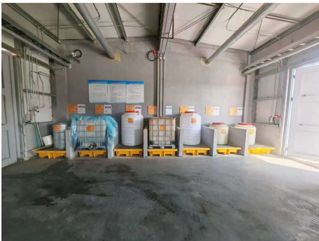
图 4.1-4 厂区危废暂存库及内部
